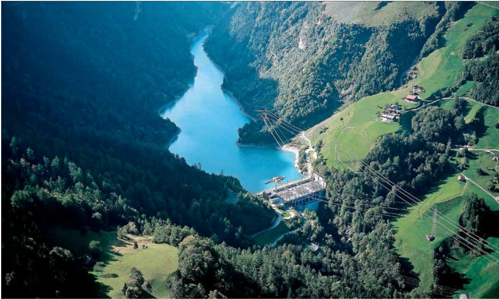
Ein Schwergewicht bei der Wasserkraftnutzung in der Region: Das Stauwerk Mapragg in der Gemeinde Pfäfers.
