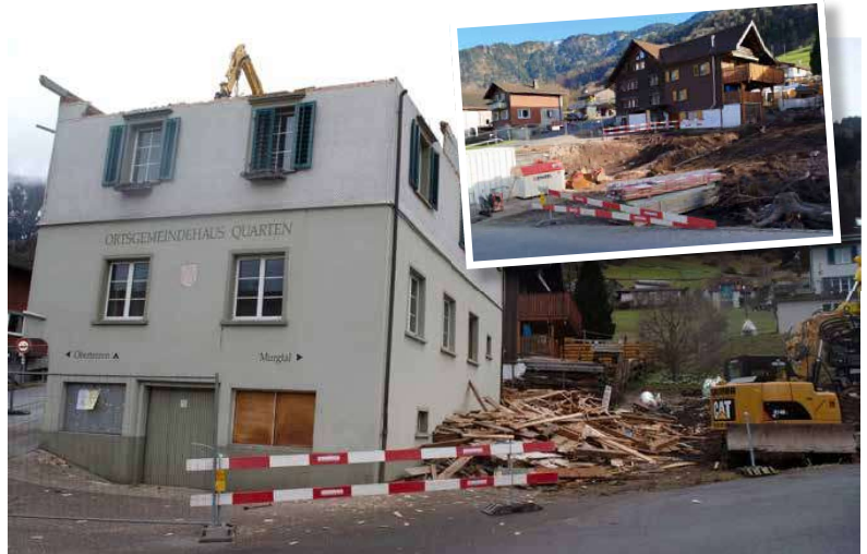
Im Ende Februar rückgebaut worden: Das Quartner Ortsgemeindehaus, das einst ein Schulhaus war.
