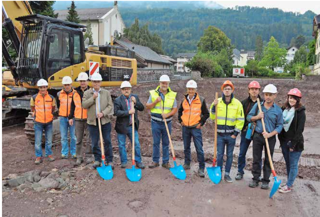
Sie glauben an die Zukunft von Flums: Mit dem Vertreter der Bauherrschaft, Thomas Schlegel (Mitte), begehen die weiteren Bauherren mit Architekten, Fachplanern, Baueingabern, Bauleitern und Baumeistern den Spatenstich des Justushofs Flums. Bild Axel Zimmermann
