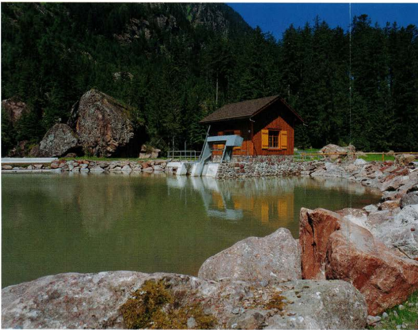
Schieberhaus Merlen mit Rechenreinigungsanlage.
