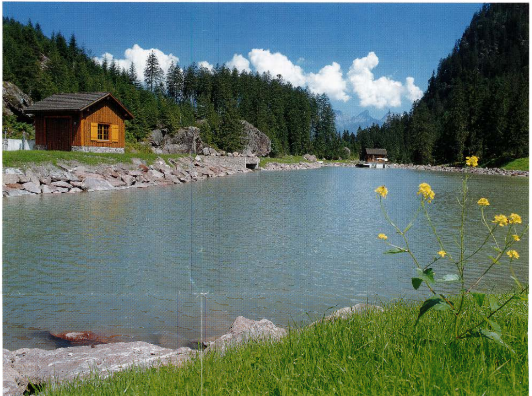
Ausgleichsbecken Merlen mit Betriebsgebäuden.
