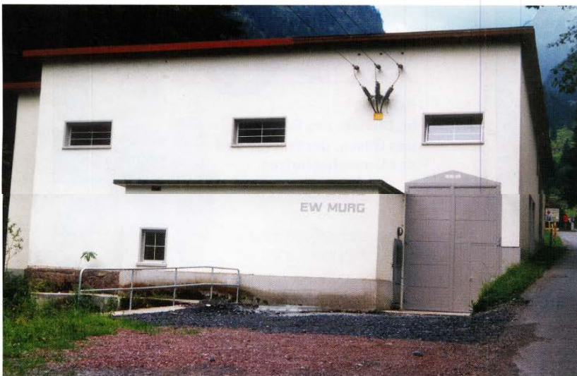
Ausgebaute Zentrale Plätz.
