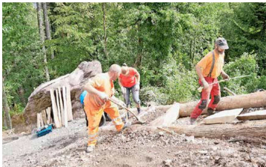
Bei der Abkürzung «Gand - Hafbüechli»: Die Gruppe mit Werkmeister Hansruedi Meier erstellt eine Treppe.
